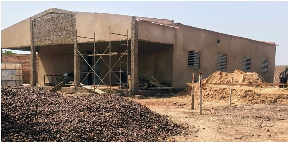
Abbildung 7: Der Rohbau des ersten Internatsgebäude für 20 Kinder, finanziert durch die Stiftung Fly&Help
